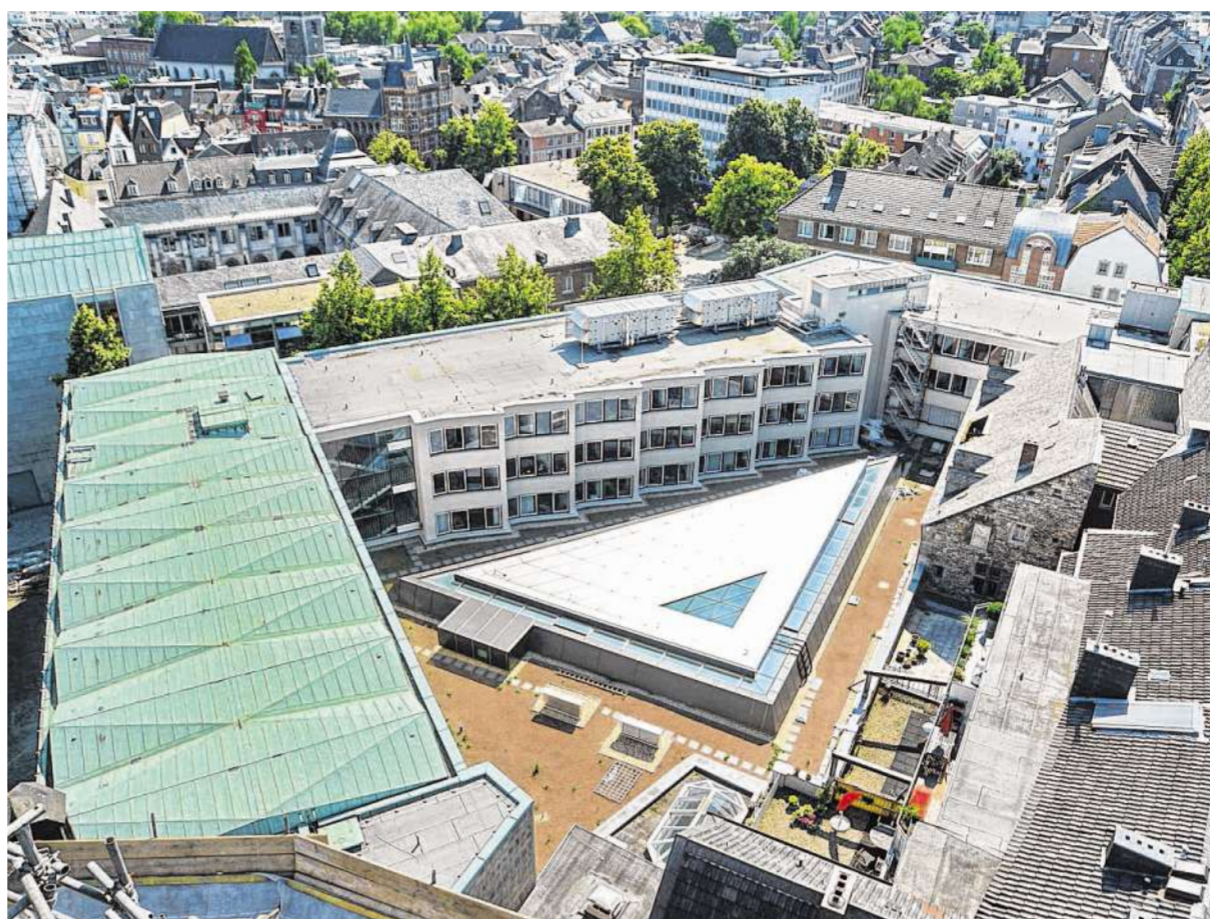
Einmaliger Blick: Vom Marienturm aus kann man das neue Dach des Centre mitsamt aufwendiger Dreiecks-Konstruktion gut sehen. Links liegt der Katschhof, hinterm Verwaltungstrakt ist die Ritter-Chorus-Straße.
